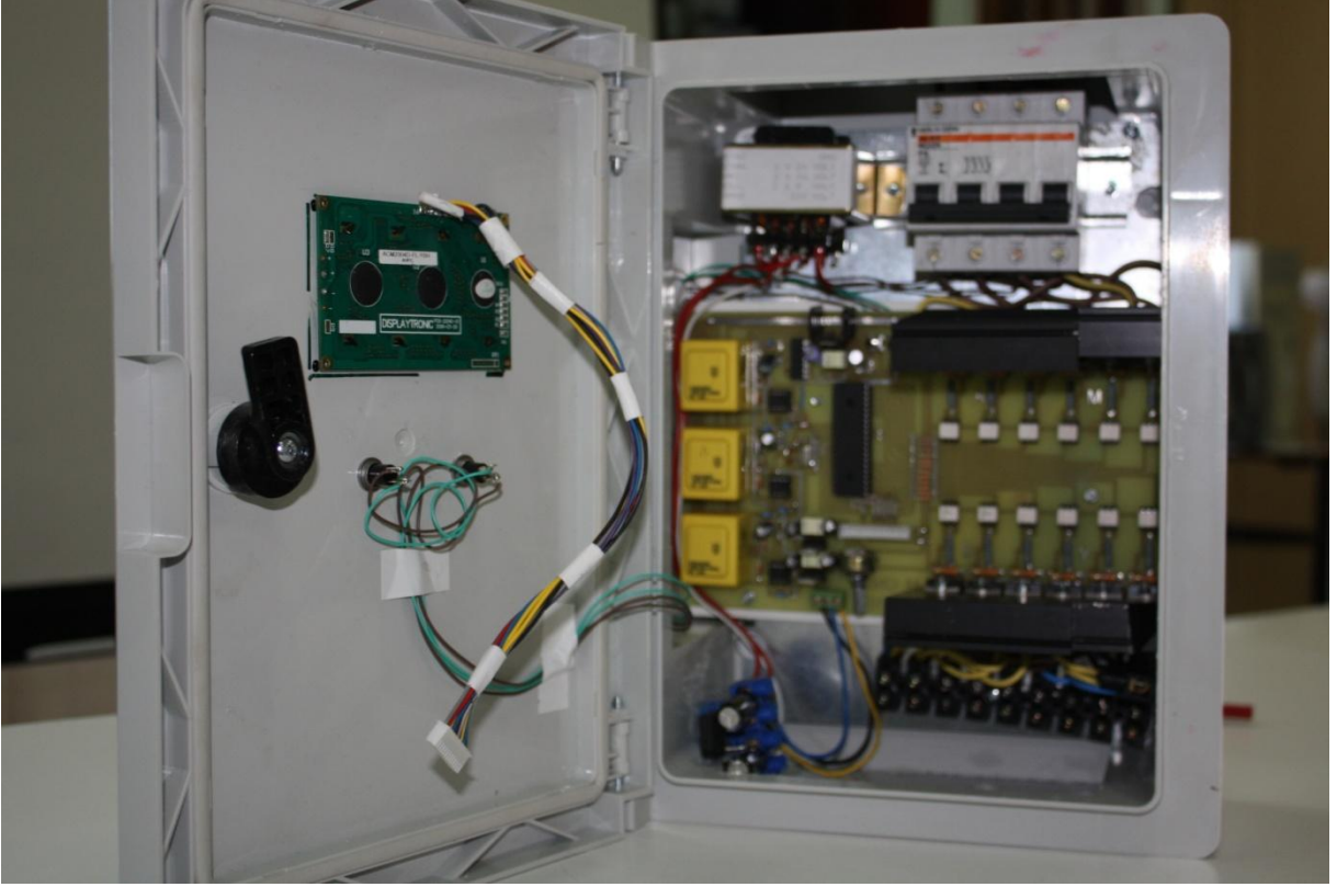
Şekil 5.7 Yapılan çalışmaya ait panonun iç görünümü
