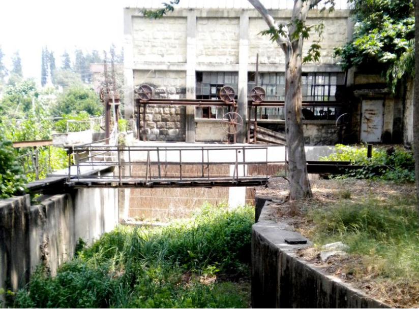
Berdan Nehrinden açılan 1600 metrelik kanal ve Çukurova Fabrikası içindeki elektrik üretim tesislerinin yer aldığı binanın dışarıdan görünümü
