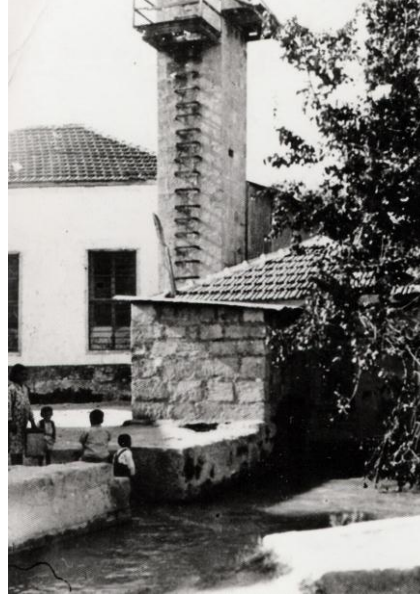
Tarsus'un ilk trafosu ve elektrik dağıtım şebekelerinden olan yapının görünümü
