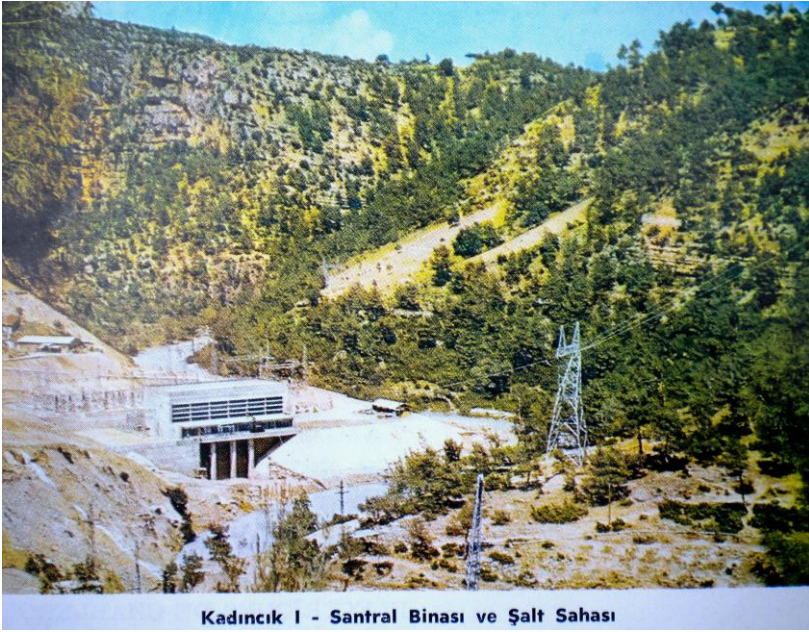
Kadıncık I - Santral Binası ve Şalt Sahası
