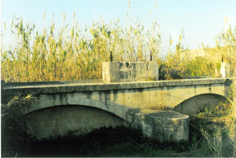
Elektrik bendinin 2004 yılındaki görünümü
