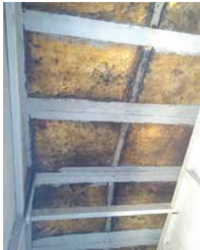
Saç KÖK Merkez AG BAR24 bölümü ve hiçbir yanık izi olmayan çatı izolasyonu
