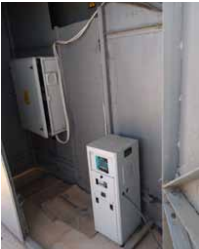
Saç KÖK Merkez AG BAR24 bölümü ve hiçbir yanık izi olmayan çatı izolasyonu
