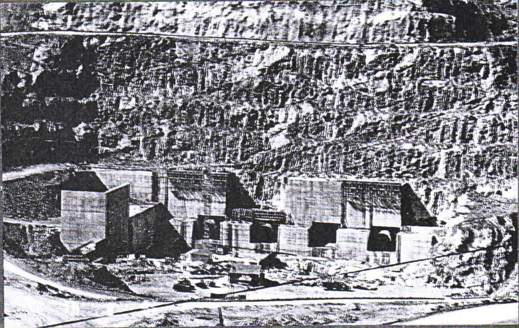
Altınkaya Barajı ve H.E. Santrali
