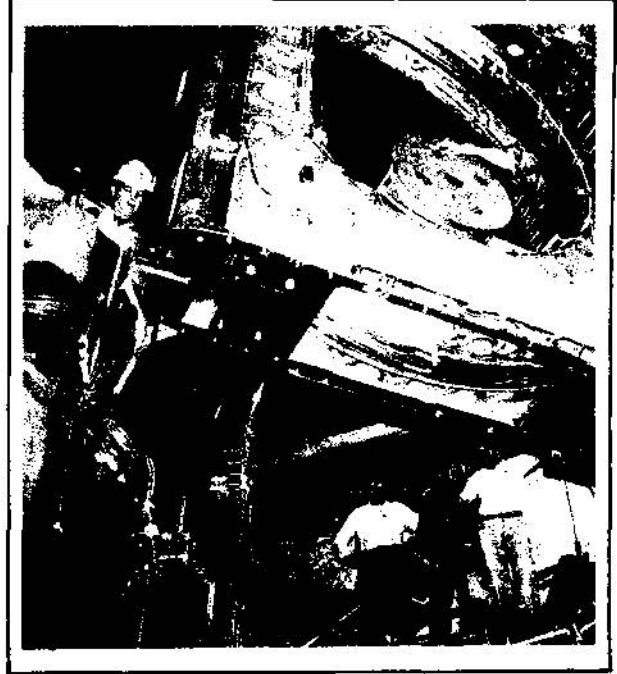
ŞEKİL 5. Siemens firmasının ürettiği NMR görüntüleme aygıtında kullanılan dev süperiletken mıknatıs.
