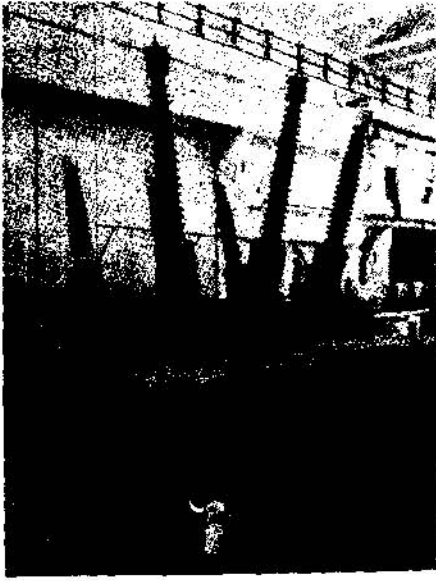
Şekil 18. Üç fazlı transformatör 700 MVA, "400/218/20kV"
