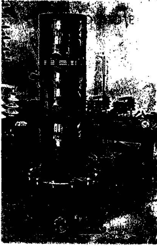
Besim : 1 — 154 kV. Kaskat Gerilim Transformatorü.
