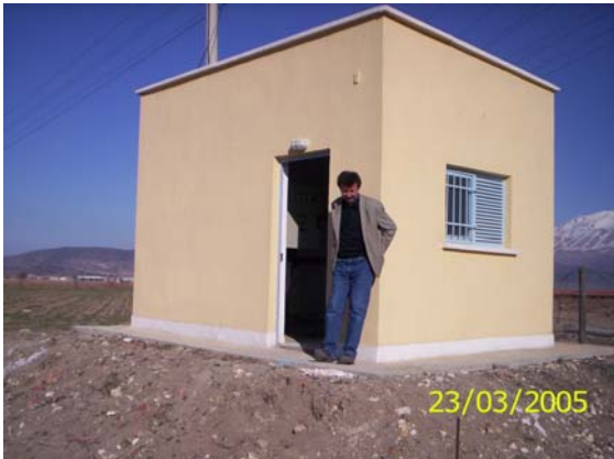
Şekil-13. TR 4 Nolu Dalgıç pompa binası
