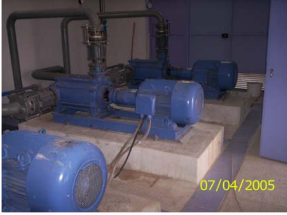
Şekil-9. Yatay Milli Pompalar
