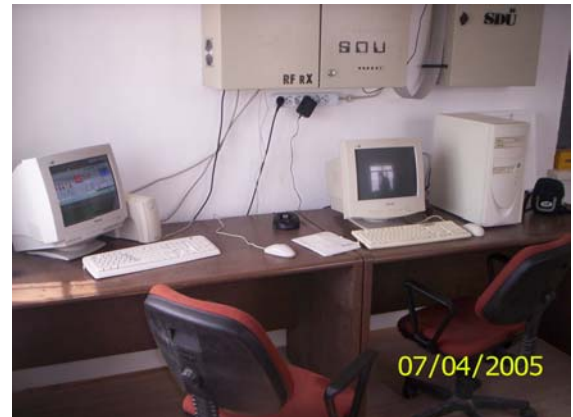
Şekil-7. SKOP V25 Kontrol panosu
