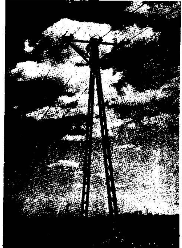
Şekil 22. OG hava hatları için rigid destek direği.
