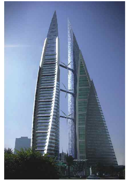
Bahrein Dünya Ticaret Merkezi Manama-Bahrein "Dünyanın ilk rüzgar türbini entegre yüksek binası" 29 m kanat çaplı 3 adet yatay eksenli rüzgar türbinin, bina enerjisinin %15'ini karşılaması bekleniyor
