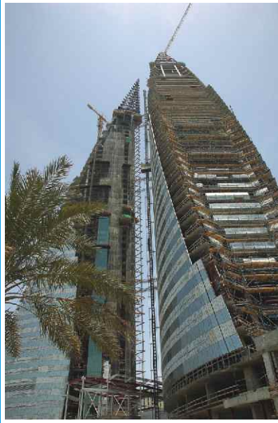
Bahrein Dünya Ticaret Merkezi Manama-Bahrein "Dünyanın ilk rüzgar türbini entegre yüksek binası" 29 m kanat çaplı 3 adet yatay eksenli rüzgar türbinin, bina enerjisinin %15'ini karşılaması bekleniyor
