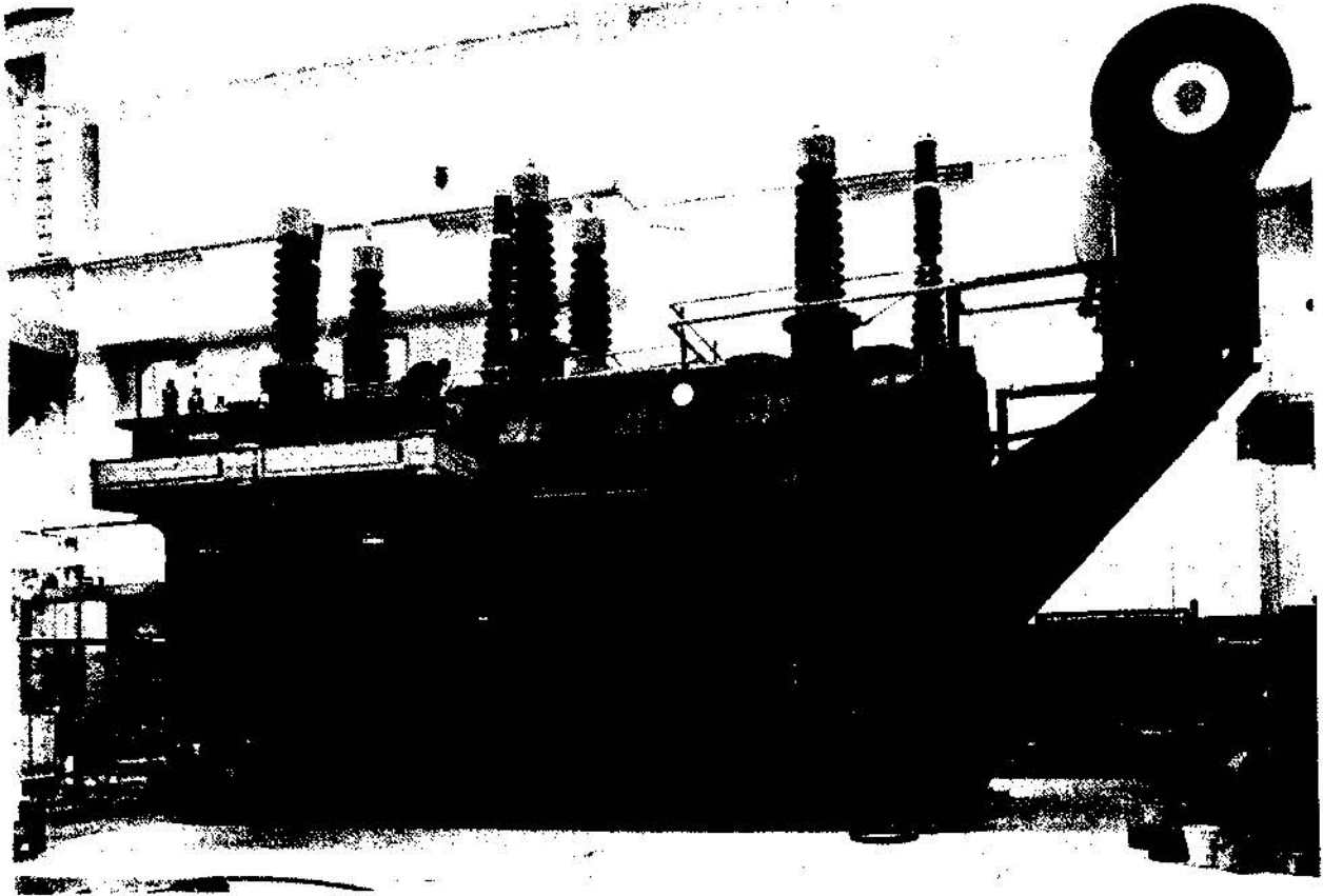
Şekil 10. 500 MVA'lık 140 kV \pm % 10 gerilim ayarı yapan bir transformatör
