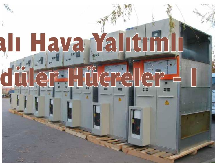
OG metal mahfazalı hava yalıtımlı dolap tipi modüler hücreler; TS IEC 622271-200 standardına, TEDAŞ MYD/95-007.D Teknik Şartnamesi'ne, Kuvvetli Akım Tesisleri Yönetmeliği ve Elektrik Tesislerinde Topraklamalar Yönetmeliği'ne uygun olarak üretilmektedir. Ayrıca hücre içerisinde kullanılan ayırıcı, kesici, bara, sigorta, sayaç, ölçü aletleri, röle, akım ve gerilim transformatörleri vb. her türlü malzeme de üretim standartlarına uygun üretilmiş olmalıdır.
