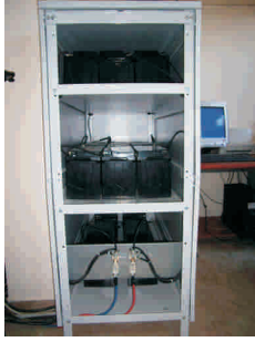
Şekil 4: Sistem akü kabineti
