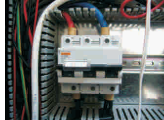
Şekil 16. Akü hattı voltaj ölçüm noktası
