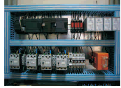
Şekil 9. PLC tabanlı veri toplama ve kontrol sistemi
