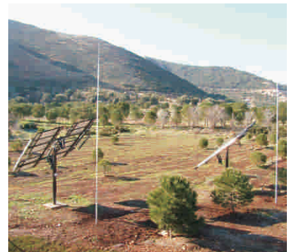
Şekil 3. Sıvı bazlı güneş takip düzeneği üzerindeki fotovoltaik paneller
